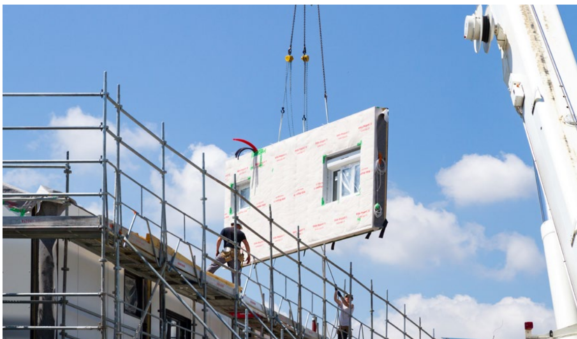
Instalacja prefabrykowanych ścian izolacyjnych w Longueau we Francji. Fot. Fabrice Singevin
